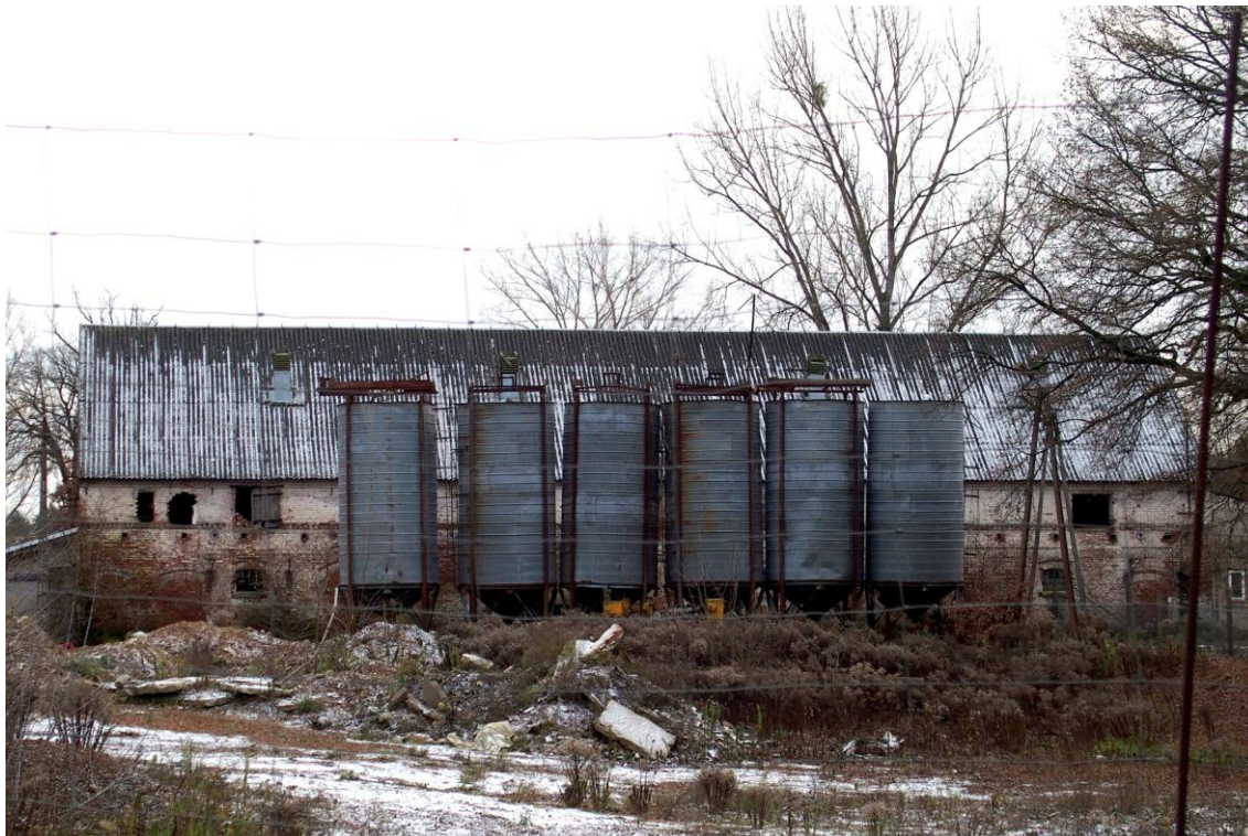
Widok budynku od północy
