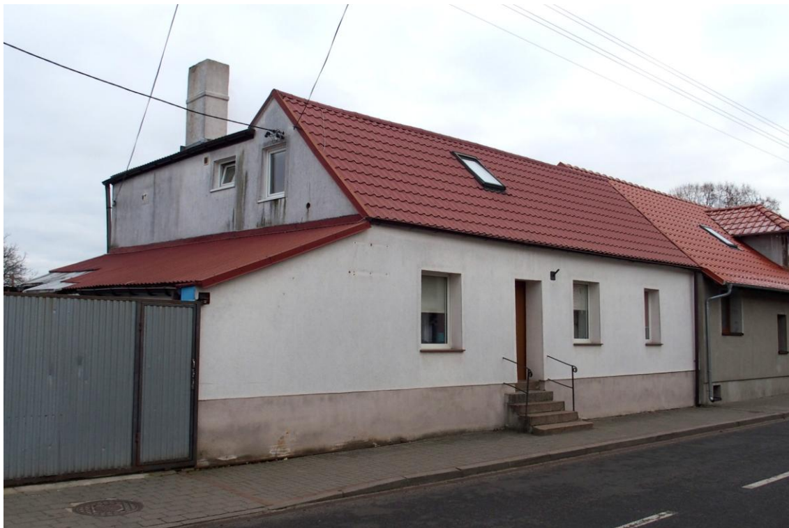
Widok budynku od północnego - zachodu
