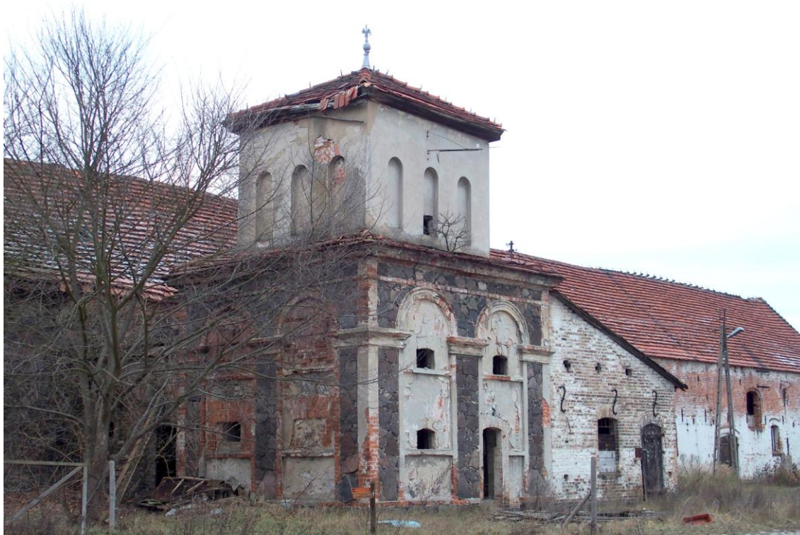
Widok budynku od południowego - zachodu
