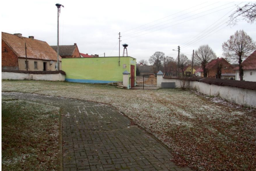
Widok od południowego - zachodu
