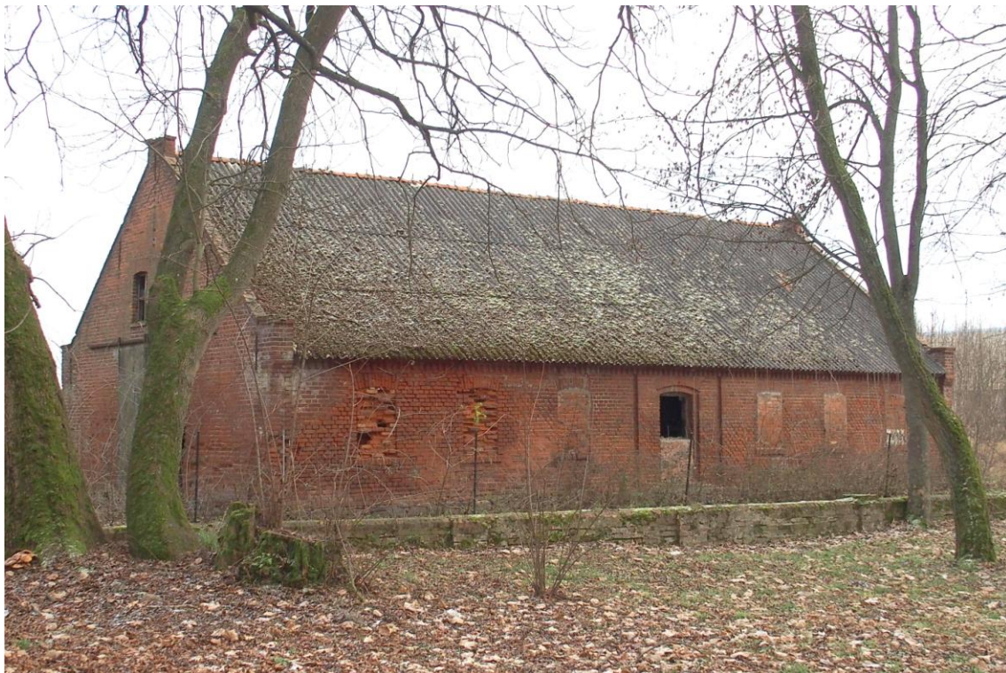
Widok budynku od północnego - zachodu
