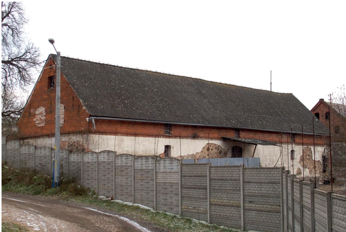
Widok budynku od północnego-zachodu
