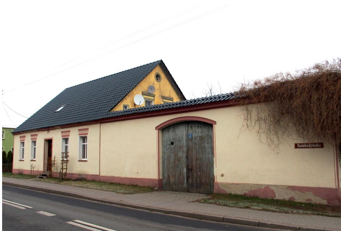
Widok budynku od południowego - zachodu
