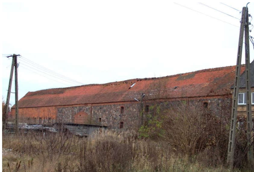
Widok budynku od północnego - zachodu
