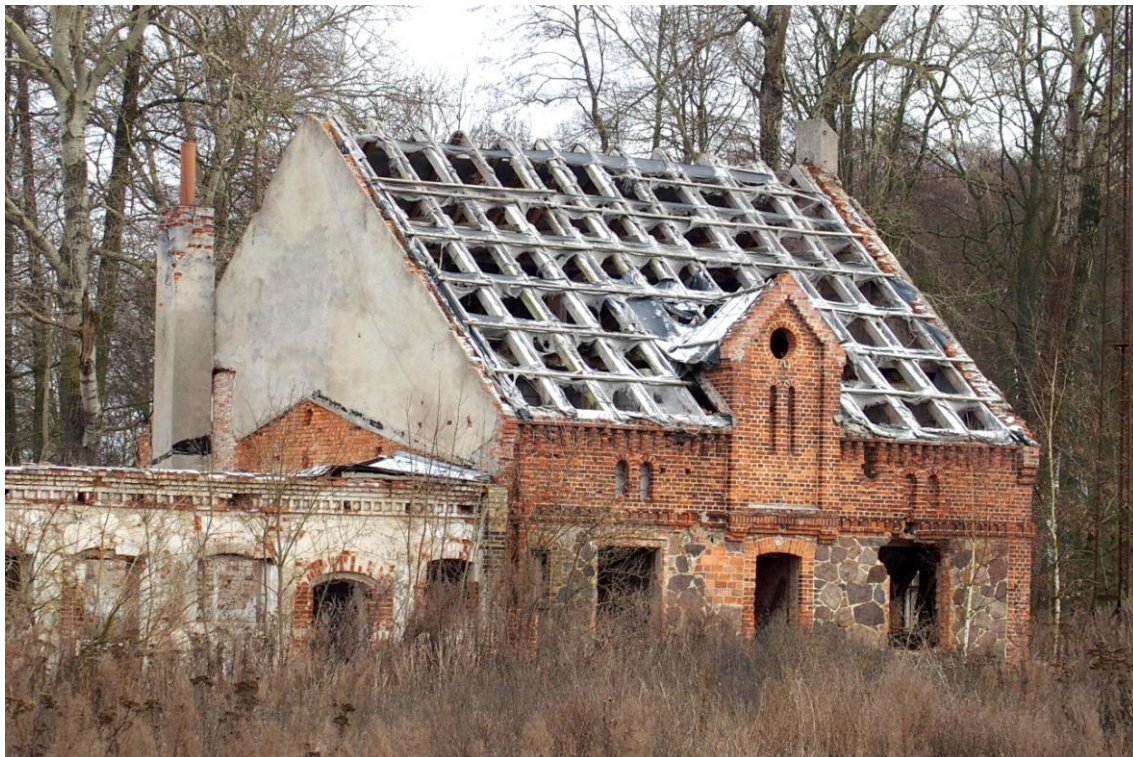
Widok budynku od północnego - zachodu
