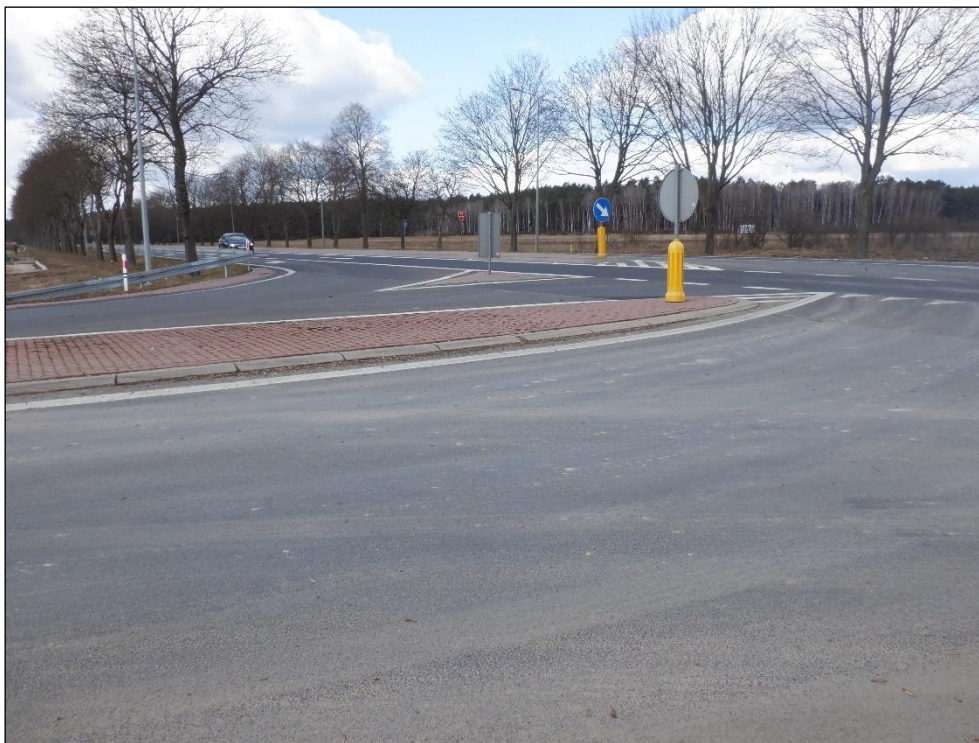
Fot. 8. Zjazd z drogi krajowej nr 92 przy wschodnim krańcu terenu mpzp.
