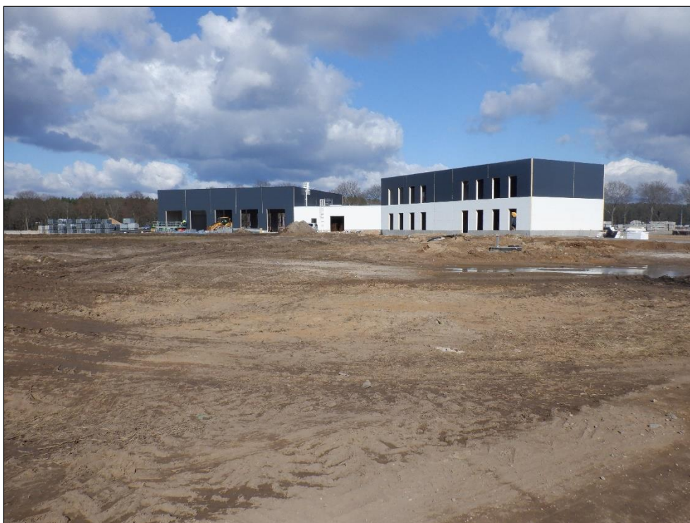
Fot. 2. Realizowana zabudowa w części wschodniej – przy zjeździe z drogi krajowej nr 92.
