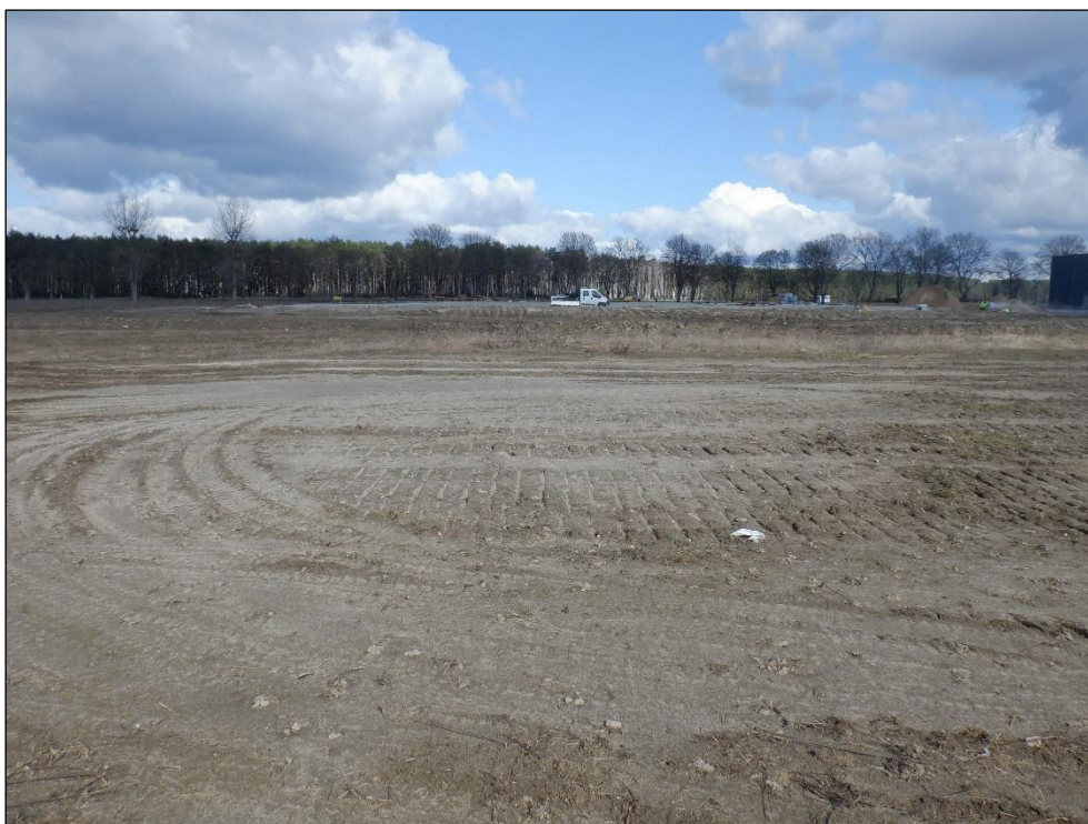
Fot. 6. Widok na centralną część obszaru opracowania – w kierunku drogi krajowej nr 92.
