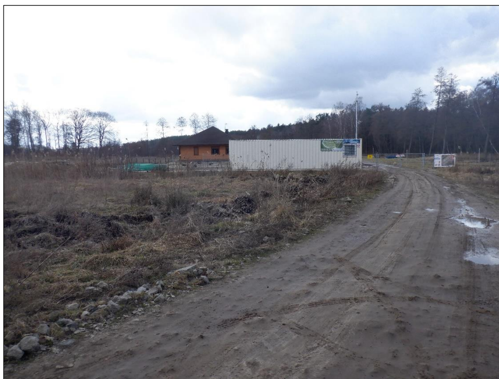
Fot. 1. Wjazd na teren „Osiedla Wenecja” od strony północnej.
