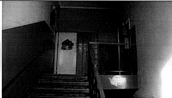
Widok na spocznik piętra. Widoczna zasłona wydzielająca magazyn na piętrze.
