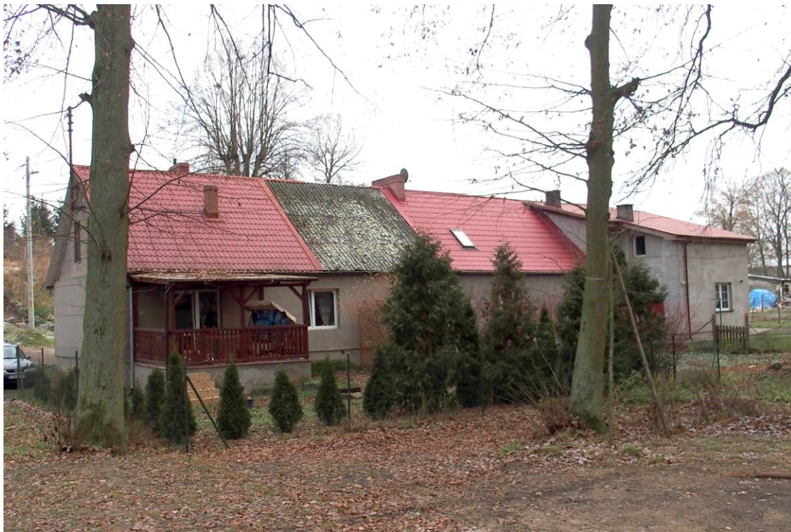
Widok budynku od północnego-zachodu
