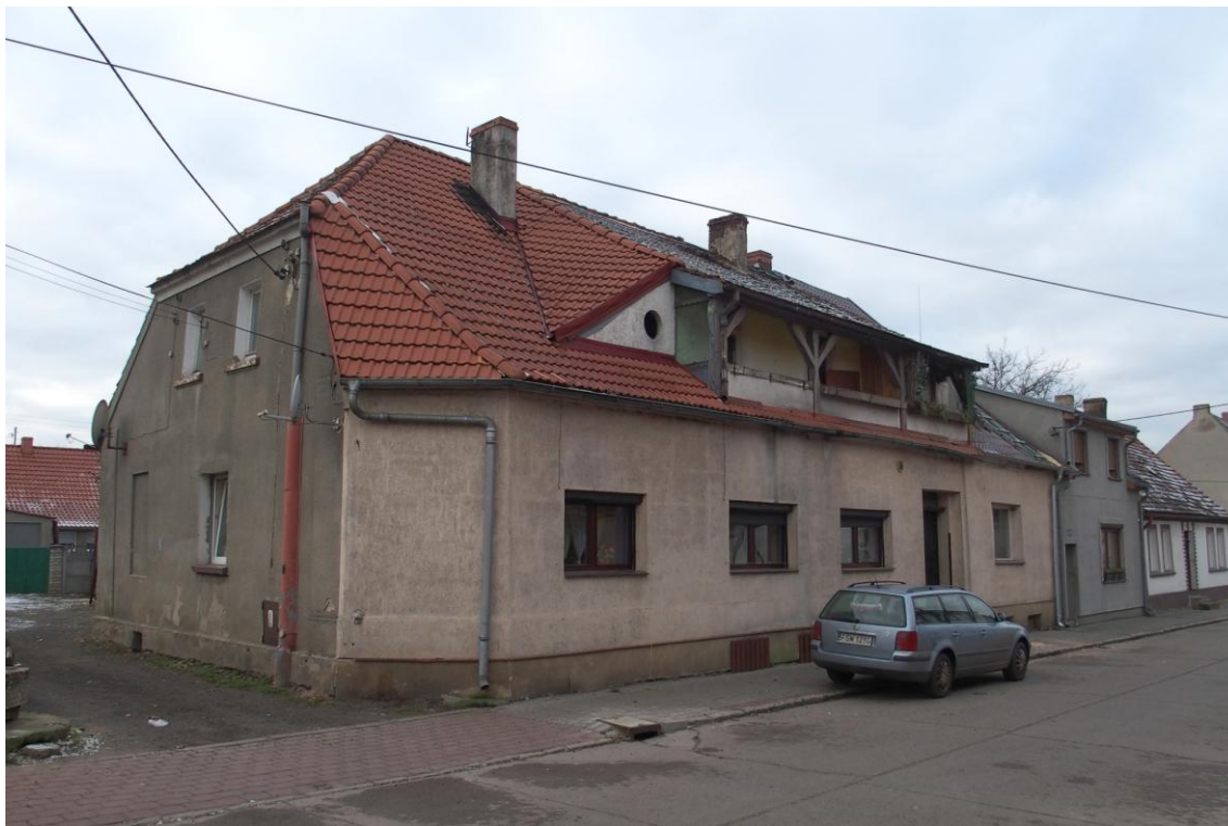
Widok budynku od wschodu
