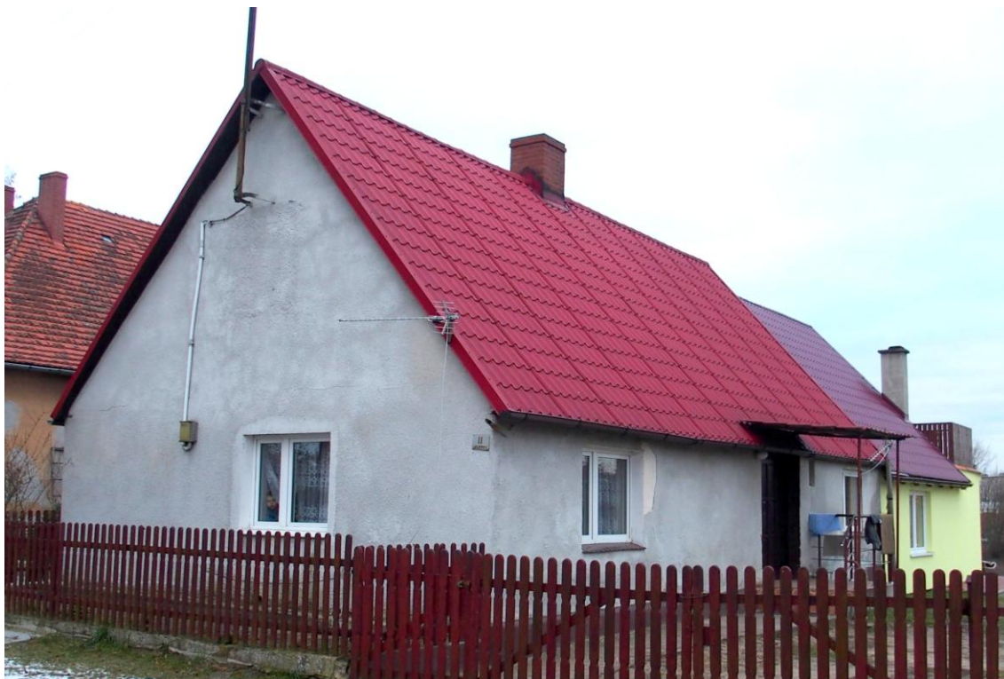
Widok budynku od północnego - zachodu
