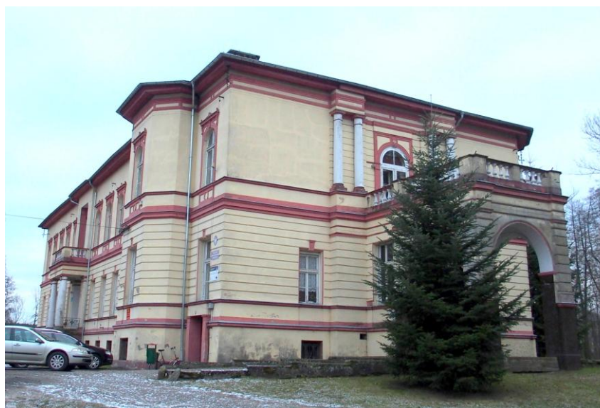
Widok budynku od północy
