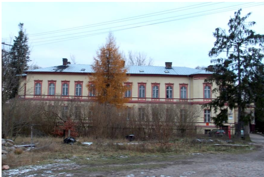
Widok budynku od północnego - wschodu
