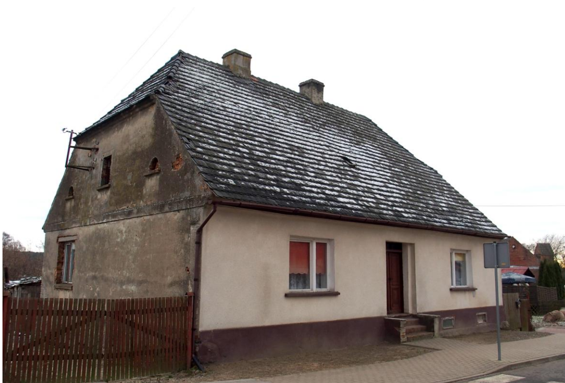
Widok budynku od północnego - zachodu
