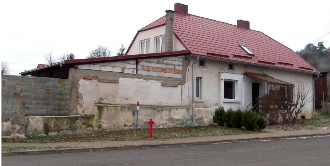
Widok budynku od północnego - wschodu
